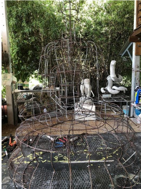
ภาพที่ ๓๘ : ภาพระหว่างการติดตามการก่อสร้างระยะที่ ๑
