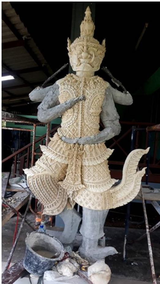
ภาพที่ ๔๗ : ภาพระหว่างการติดตามการก่อสร้างระยะที่ ๒
